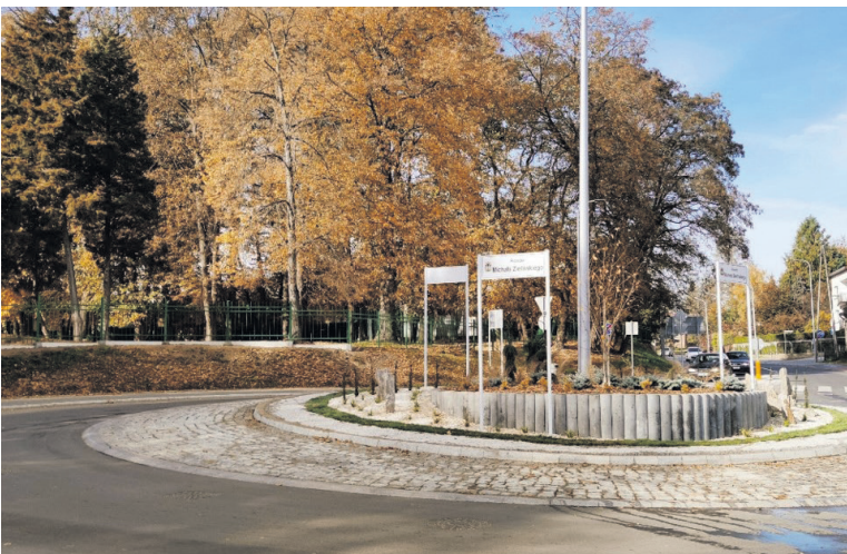
ul.Kraszewskiego - po przebudowie
