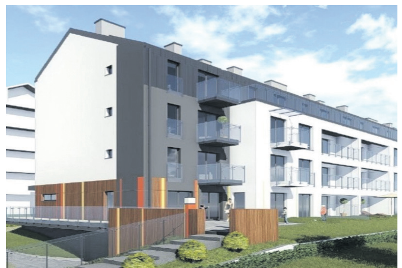
Budowa bloku dla młodych rodzin
